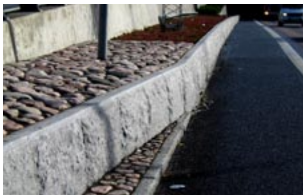
Fig 8.48 Blockstensmur av granit som stödmur och trafikbarriär
