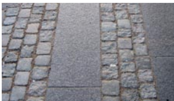
Fig 4.4 Granithäll med klippt kant mot gatstensbeläggning
