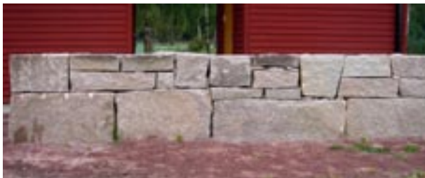
Fig 8.7 Kallmur av granitblock i rubbelförband
