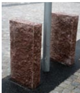
Fig 10.9 Påkörningsskydd av råkilad granit.
