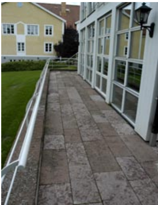
Fig 4.3 Tophyvlade kalkstenshällar i fallande längder
