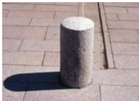
Fig 10.3 Cylindrisk, krysshamrad granitpollare. Rännstensplattor av flammad granit.
