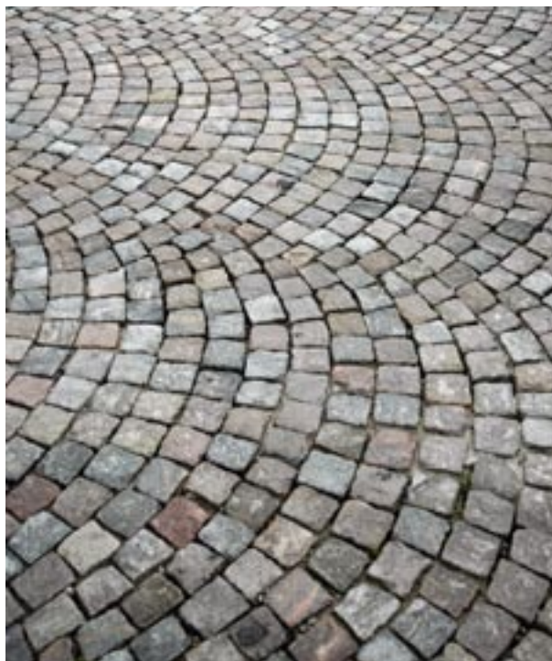
Fig 5.7 Bågsättning med smågatsten
