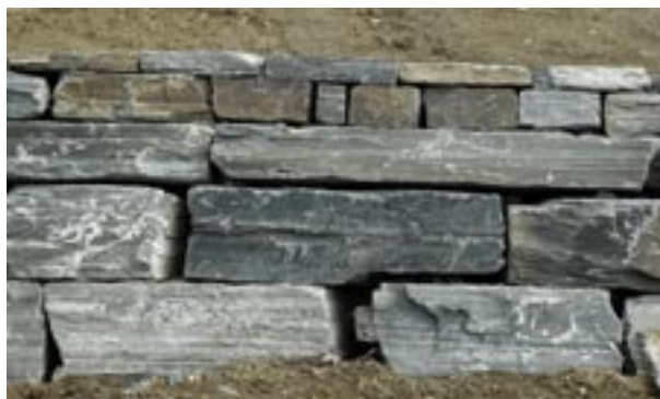
Fig 8.18 Kallmur av staplade skifferblock i kvaderförband.
