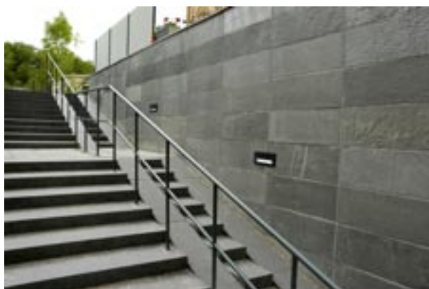
Fig 7.25 Barnvagnsramp integrerad i blockstegstrappa. Beklädnadsmur med skiffer.
