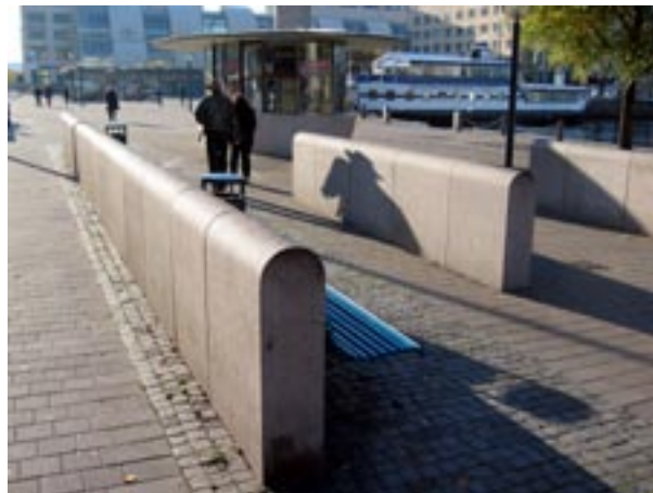
Fig 8.26 Blockstensmurar av flammad granit.
