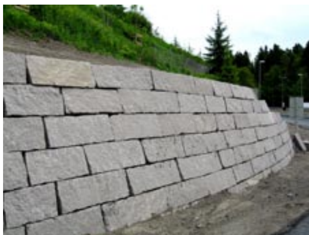
Fig 8.29 Kallmur av granitblock i vägsärning.
