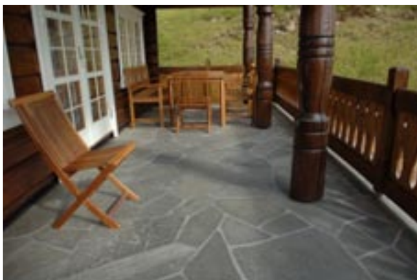
Fig 4.29 Altanbeläggning, skiffer med klovtyta.
