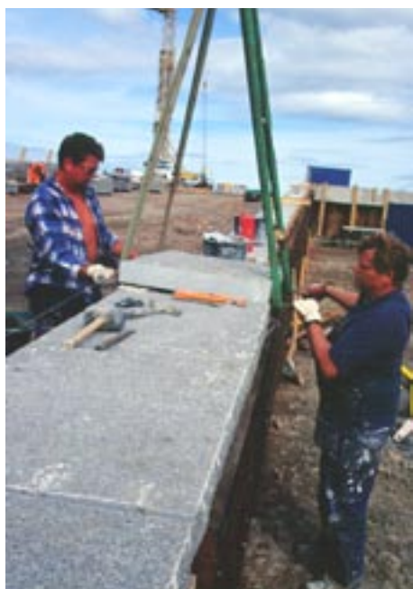
Fig 8.46 Granitavtäckning monteras
