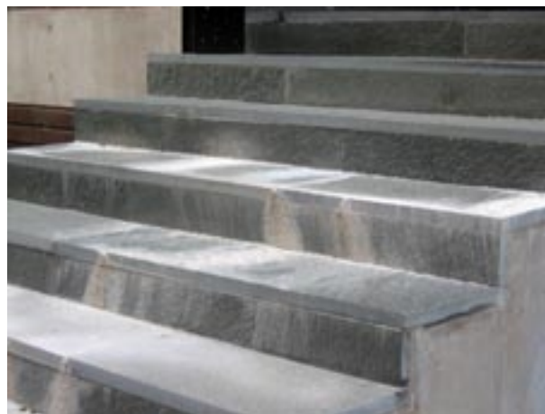
Fig 7.32 Misspyrdande salt- och kalkutfällningar, som är svåra att avlägsna. Sådana bildas när stora mängder vatten transporteras genom cementbruk.
