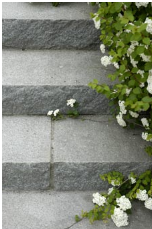
Fig 7.2 Blockstegtrappa av granit. Krysshamrad ovarsida och råkilad framsida.
