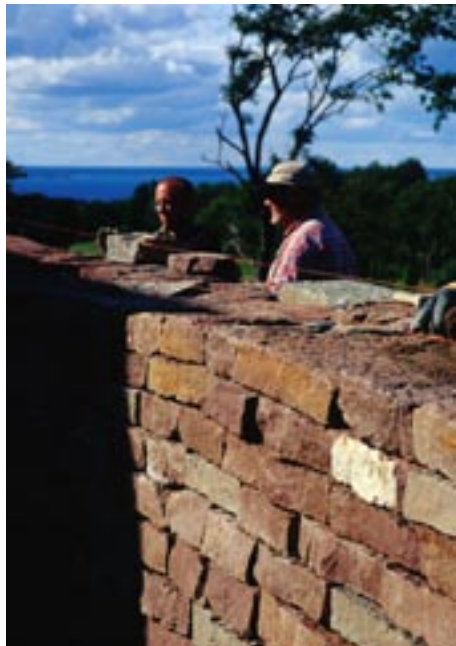
Fig 8.30 Montering av kalkstensskivor "flis" som kallmur.
