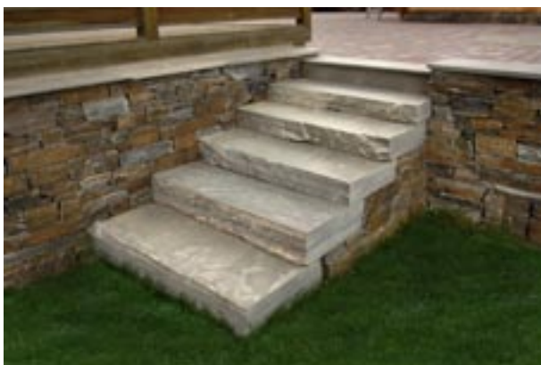
Fig 7.10 Blockstegstrappa av skiffer i anslutning till skifferkallmur.
