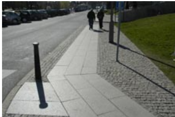
Fig 5.6 Rak stensättning med granithällar inlagda som gångyta.
