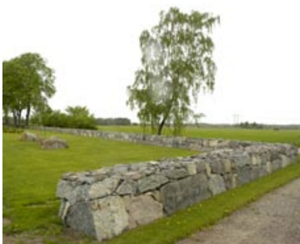
Fig 8.27 Kallmur av lokal sten, s k kyrkogårdsmur.
