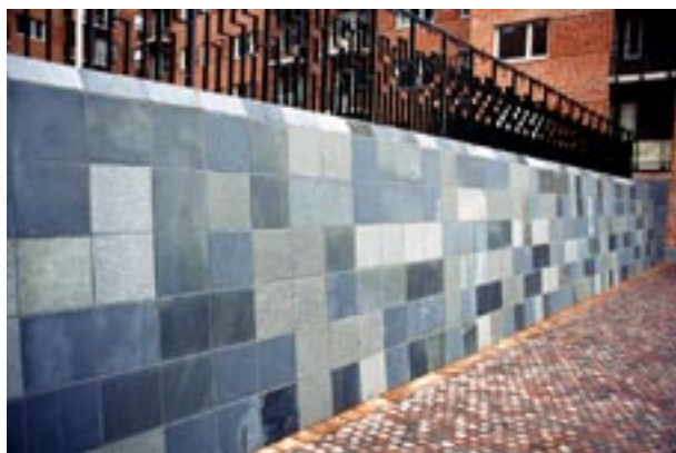
Fig 8.16 Beklädnadsmur. Skiffer med olika ytbearbetningar, klovyta, slipad och polerad. Kvadratiske plattor i ruttmönster.
