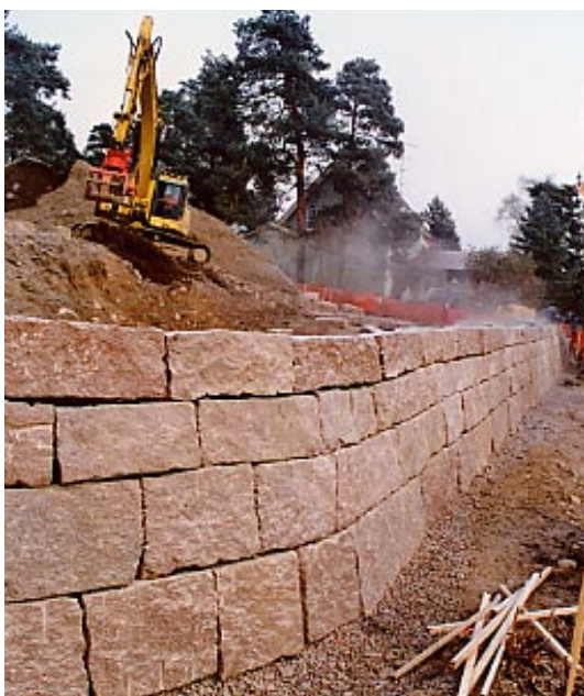
Fig 1.2 Kallmur av staplade råblock
