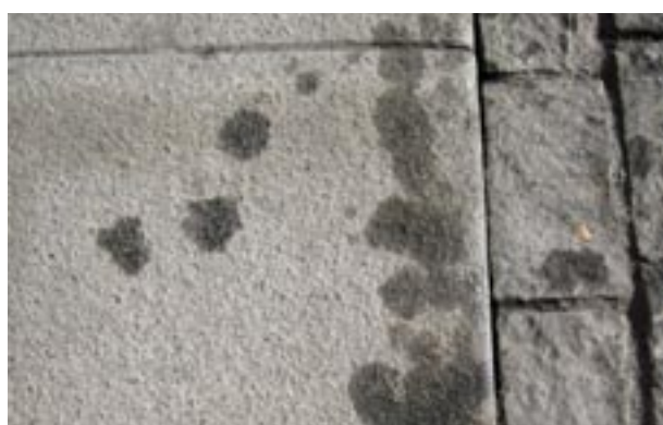
Fig 11.4 Misspdydande oljefläckar på granitramsten.
