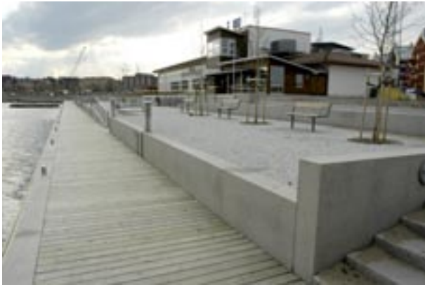
Fig 9.2 Kajanläggning uppbyggd av granitblock med flammad yta.
