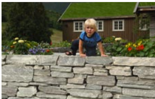
Fig 8.17 Kallmur av staplade skivor av skiffer
