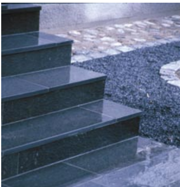
Fig 7.13 Beklädnadstrappa med steg av skiffer
